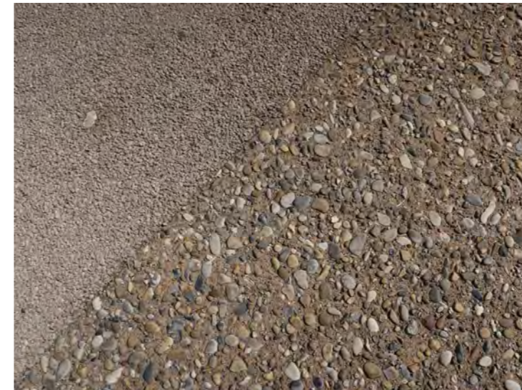
Stabilisé sablé coloré et béton désactivé gros granulat ...
