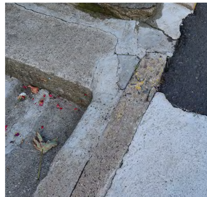
Dalle béton armé, ciment blanc et divers ragréages ...
