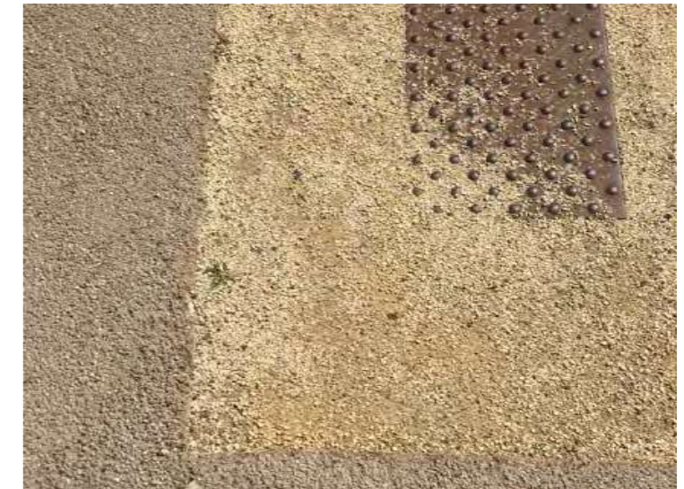
Stabilisé sablé coloré et béton désactivé gros granulat ...
