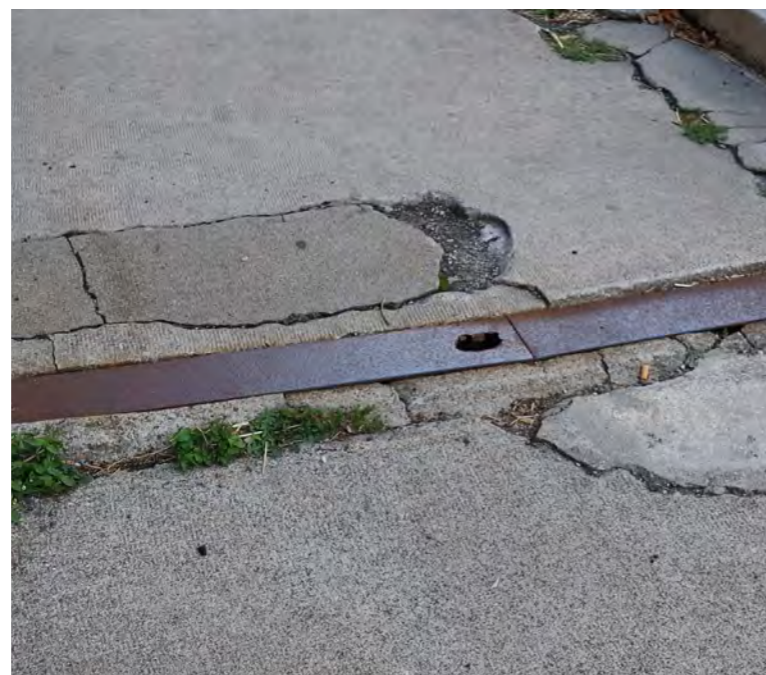
Dalle béton armé, ciment blanc et divers ragréages ...
