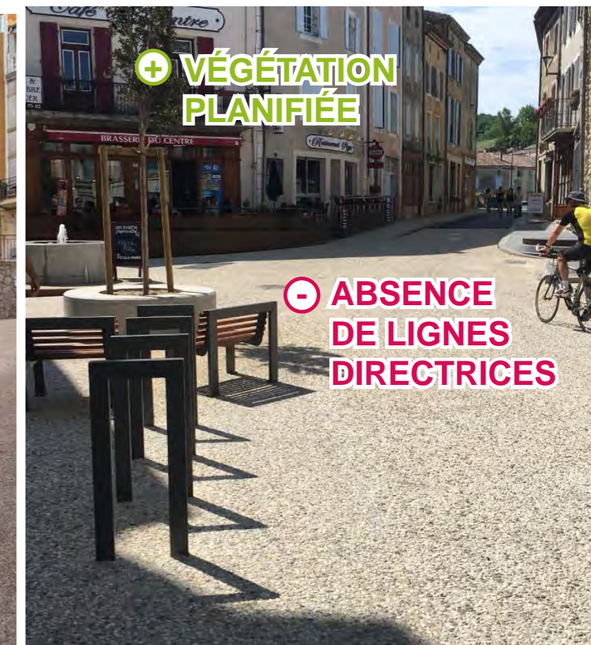
Béton désactivé en coeur de village Bourdeaux (26056) - Source : https://sols.fr/references/coeur-de-village-bourdeaux
